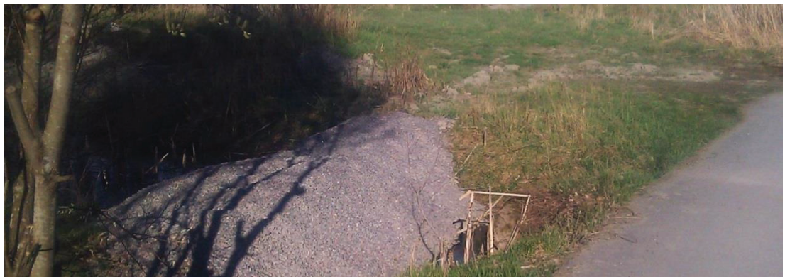
Kuva 34. Avo-ojan eteen rakennettu väliaikainen suodattava murskepato. Turku, Haarlahti.
