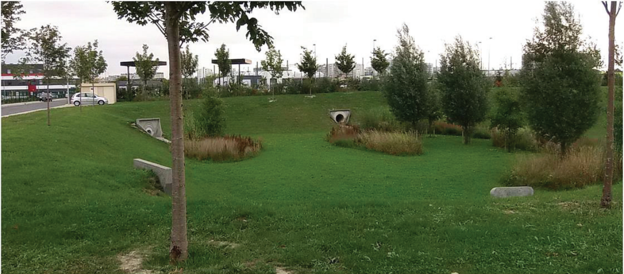
Kuva 26. Esimerkki viivytyspainanteesta, jonne hulevedet johdetaan hulevesiviemäreillä 13
