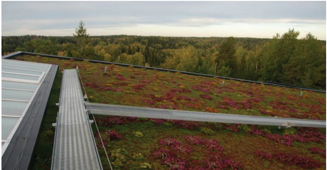
Kuva 11. Esimerkki laaja-alaisesta viherkattosta. Kohde Solvalla Urheiluopisto, Espoo.
