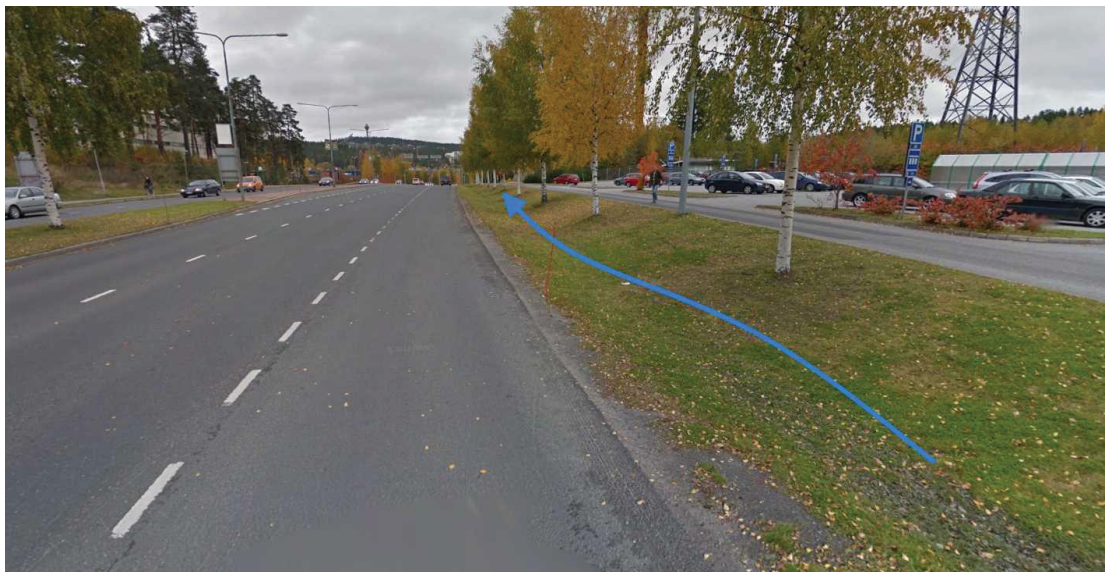
Kuva 17. Savilahdentiellä on jo nykyiselläänkin painannerakenne pintakuivatusrakenteena, jossa hulevedet osittain puhdistuvat ja imeytyvät.
