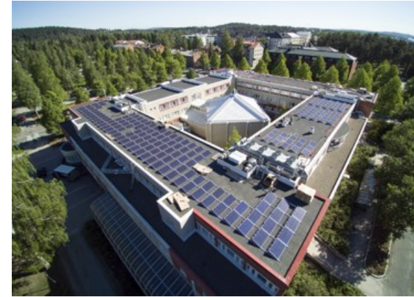
Kuva 6. Kuopion valtuustotalon aurinkovoimala otettiin käyttöön heinäkuussa 2018. Voimala tuottaa n. 8 % talon vuosittaisesta sähkön tarpeesta. Kuva: Kuopion kaupunki/Raimo Pesonen
