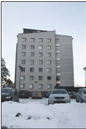
Rakennuksen luoteissivu. (Aada Mustonen 14.2.2017)
