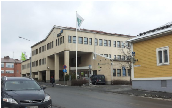
KUVA 8. ETELÄPUOLISEN TONTIN 1-7 RAKENNUS
