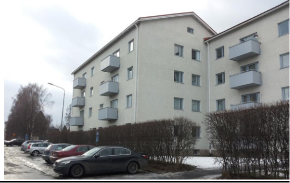
KUVA 7. LÄNSIPUOLISEN TONTIN 12-1 RAKENNUS
