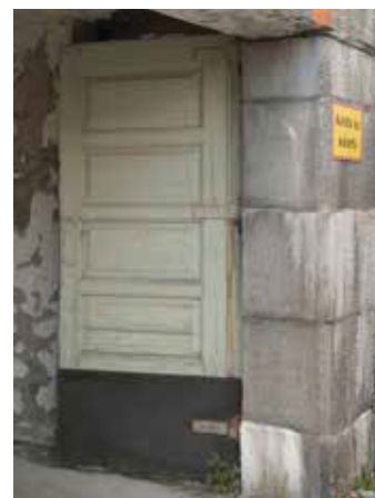
Enstisen matkatavaratunnelin yläpään ramppi suojarakennuksineen. Sisäkaton laudoitusta lukuunottamatta näkyvissä olevat puurakenteet, ikkunat yms. ovat säilyneet alkuperäisinä. Alla matkatavaratunnelin alapään aukko, jota verhoaa hakatusta graniitista tehty muuri. Alkuperäiset ovet ovat säilyneet, mutta niitä ei ole ilmeisesti käytetty vuosikymmeniin.
