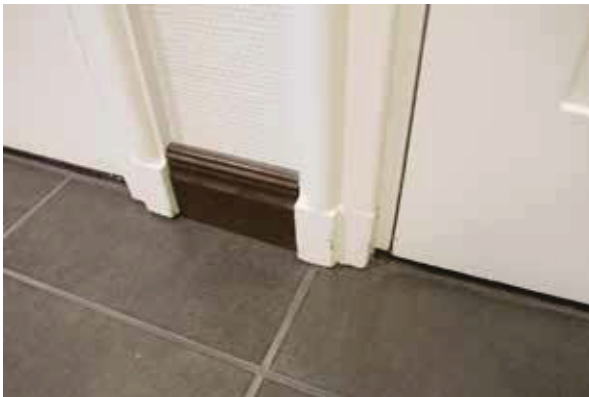
Alkuperäisiä ovien listoja ja jalkalistaa. Huomaa ovilistojen alapään jalustapalat.
