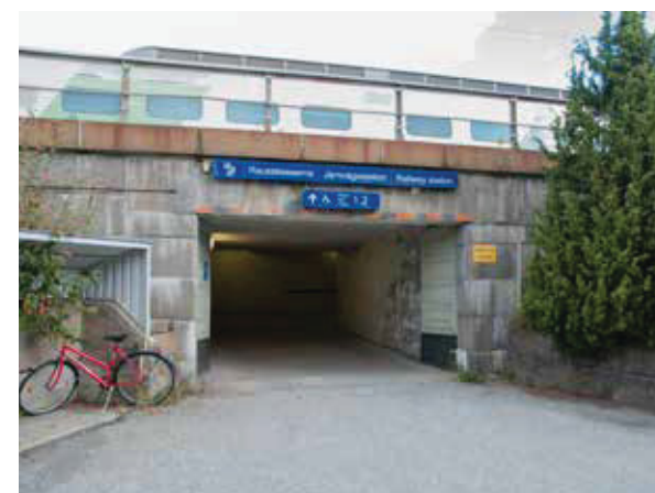
Enstisen matkatavaratunnelin yläpään ramppi suojarakennuksineen. Sisäkaton laudoitusta lukuunottamatta näkyvissä olevat puurakenteet, ikkunat yms. ovat säilyneet alkuperäisinä. Alla matkatavaratunnelin alapään aukko, jota verhoaa hakatusta graniitista tehty muuri. Alkuperäiset ovet ovat säilyneet, mutta niitä ei ole ilmeisesti käytetty vuosikymmeniin.
