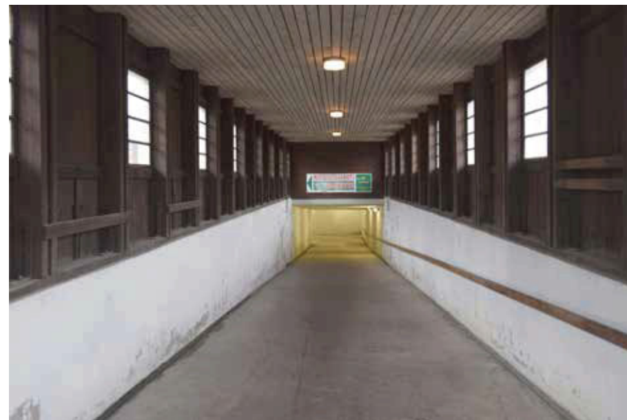
Enstisen matkatavaratunnelin yläpään ramppi suojarakennuksineen. Sisäkaton laudoitusta lukuunottamatta näkyvissä olevat puurakenteet, ikkunat yms. ovat säilyneet alkuperäisinä. Alla matkatavaratunnelin alapään aukko, jota verhoaa hakatusta graniitista tehty muuri. Alkuperäiset ovet ovat säilyneet, mutta niitä ei ole ilmeisesti käytetty vuosikymmeniin.
