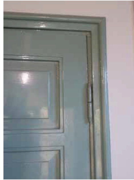
Alkuperäisiä ovia listoineen ravintolan keittiö- ja aputiloista.
