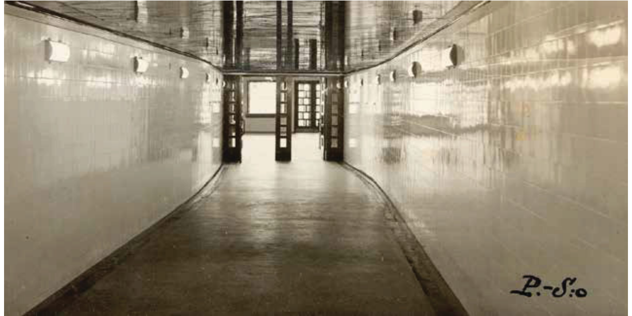
Asemalaiturille johtava matkustajatunneli heti valmistumisensa jälkeen. Katto maalattiin kiiltävällä mustalla maalilla. Savon sanomissa maaliskuun 23. päivänä vuonna 1934 ilmestyneessä artikkelissa kuvaillaan tunnelia näin: "Tunnelin seinät ovat valkeata kaakelia ja katto peilikirkaaksi maalattu. Näin ollen tunneli näyttää sangen hauskalta ja ilmavalta, sillä kiiltokatto lisää katsojan silmissä puolilla korkeutta." KUHMU.
