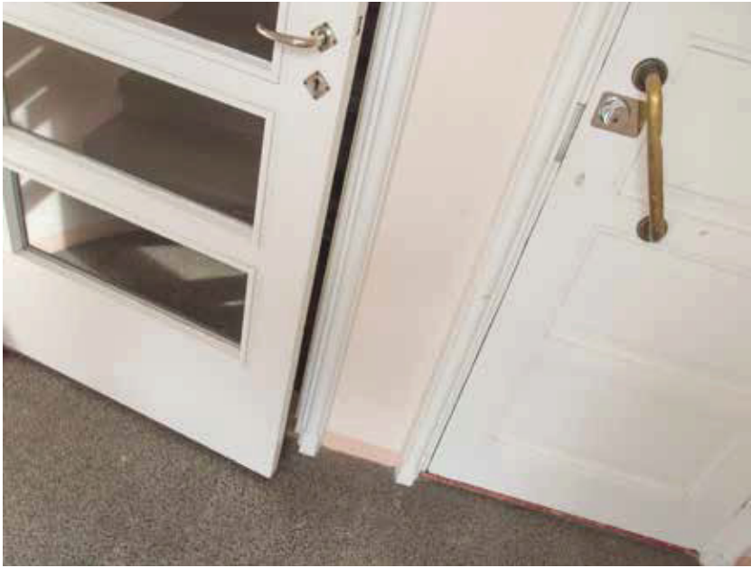
Detaljeja Rakennuksessa on säilynyt suuri määrä alkuperäisiä 1930-luvun ovia. Yllä itäpään porrashuoneeseen johtavat ovet. Myös ovien vuorilistat ovat alkuperäiset.
