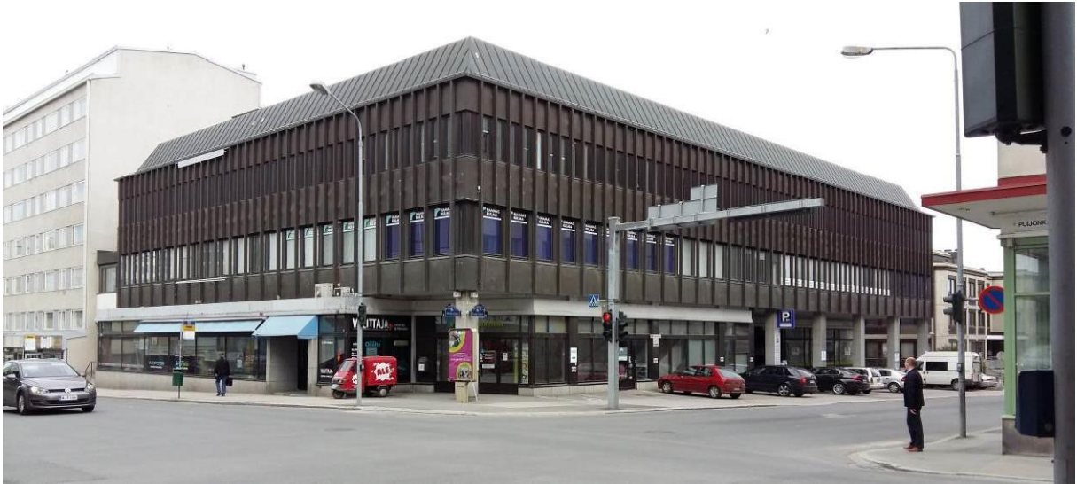
KUVA 5. SUOKADUN JA PUISTOKADUN KULMAUKSESSA SIJAITSEVA ENTINEN POSTIPANKKI
