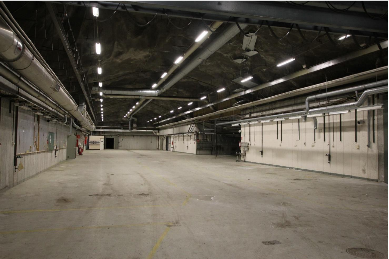
Kuva 1 Sisänäkymä olemassa olevaan varikkohalliin.
