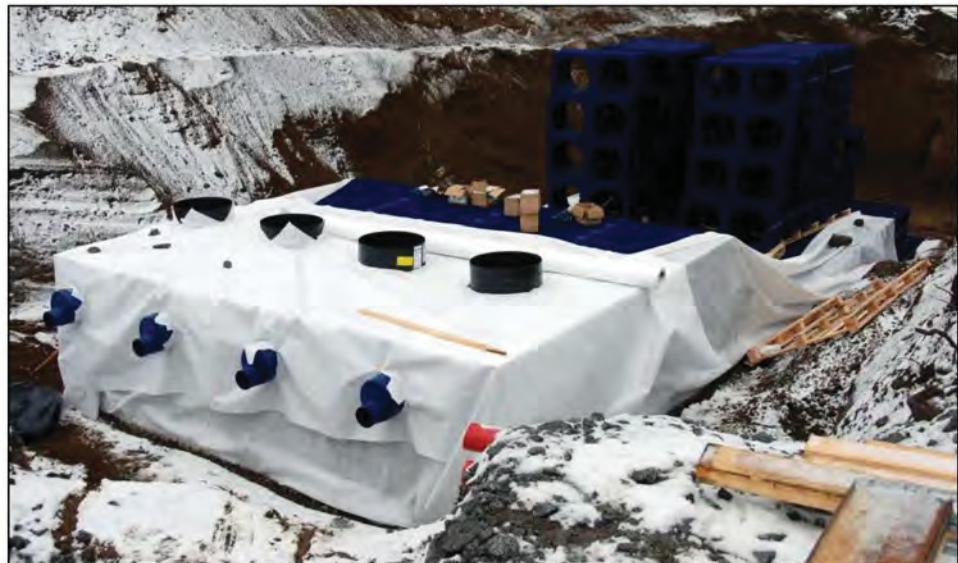
Kuva 17. Esimerkki maanalaisen kennoston rakentamisesta Tampereella. 14
