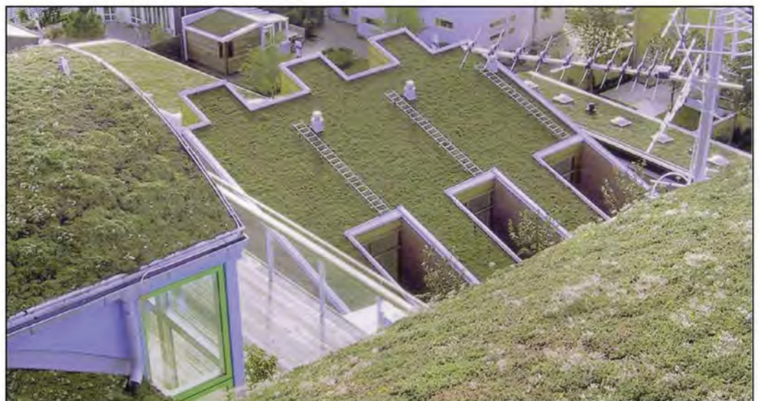
Kuva 12. Esimerkki laaja-alaisesta kattokasvillisuuden käytöstä 8 .
