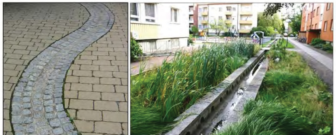
Kuva 14. Esimerkkejä hulevesien johtamisesta pintaratkaisuin 10, 11
