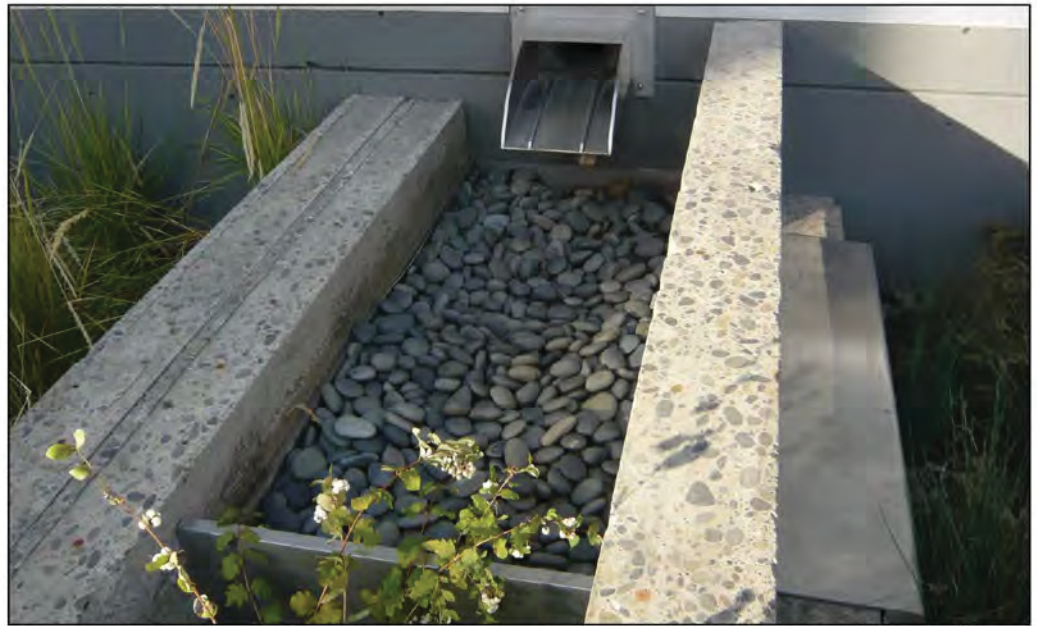
Kuva 15. Kattovedet johdetaan ensin virtaamia hidastaviin kivipesiin 12 .
