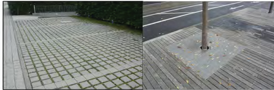
Kuva 13. Esimerkkejä läpäisevien päällysteiden käytöstä. 9
