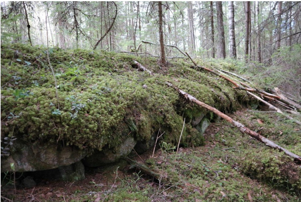
Sivutien, entinen valtatie 5, pengerrys on itäreunaltaan tuettu kiviladonnalla.
