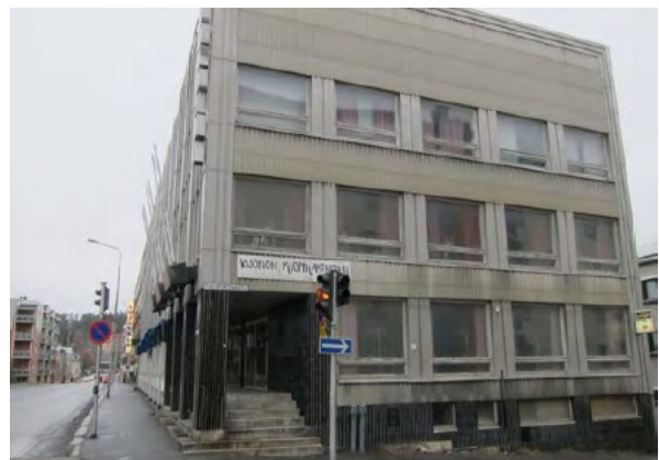
KUVA 7. TYÖNKULMA TULLIPORTINKADUN SUUNASTA
