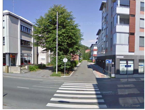
KUVA 5. KIINTEISTÖ OY KUOPION TULLIPORTIN ITÄPUOLI (NS. SEPÄNKADUN JATKE)
