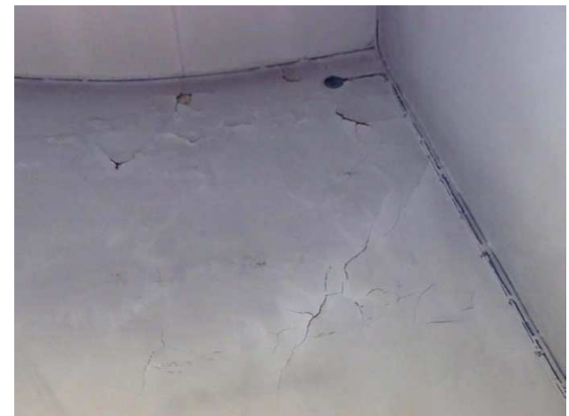
Alla: alustastaan irronneita paksuja maalikerroksia huoneen ulkoseinän yläosassa.
