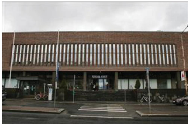
Kirjaston itäistä pääjulkisivua Maaherrankadun puolella. (Aada Mustonen 13.5.2015)
