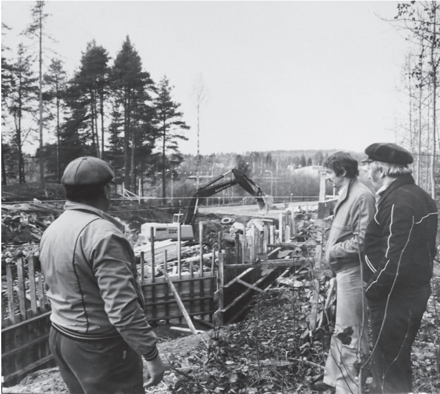
Lokakuun puolivälissä vuonna 1981 seurakuntatalon rakennustyömaan louhinta- ja kaivutyöt olivat loppuvaiheessa ja kellarikerroksen, seinien ja perusmuurien laudoitustyöt käynnissä. Kuva on otettu 16.10.1981. SRKA
