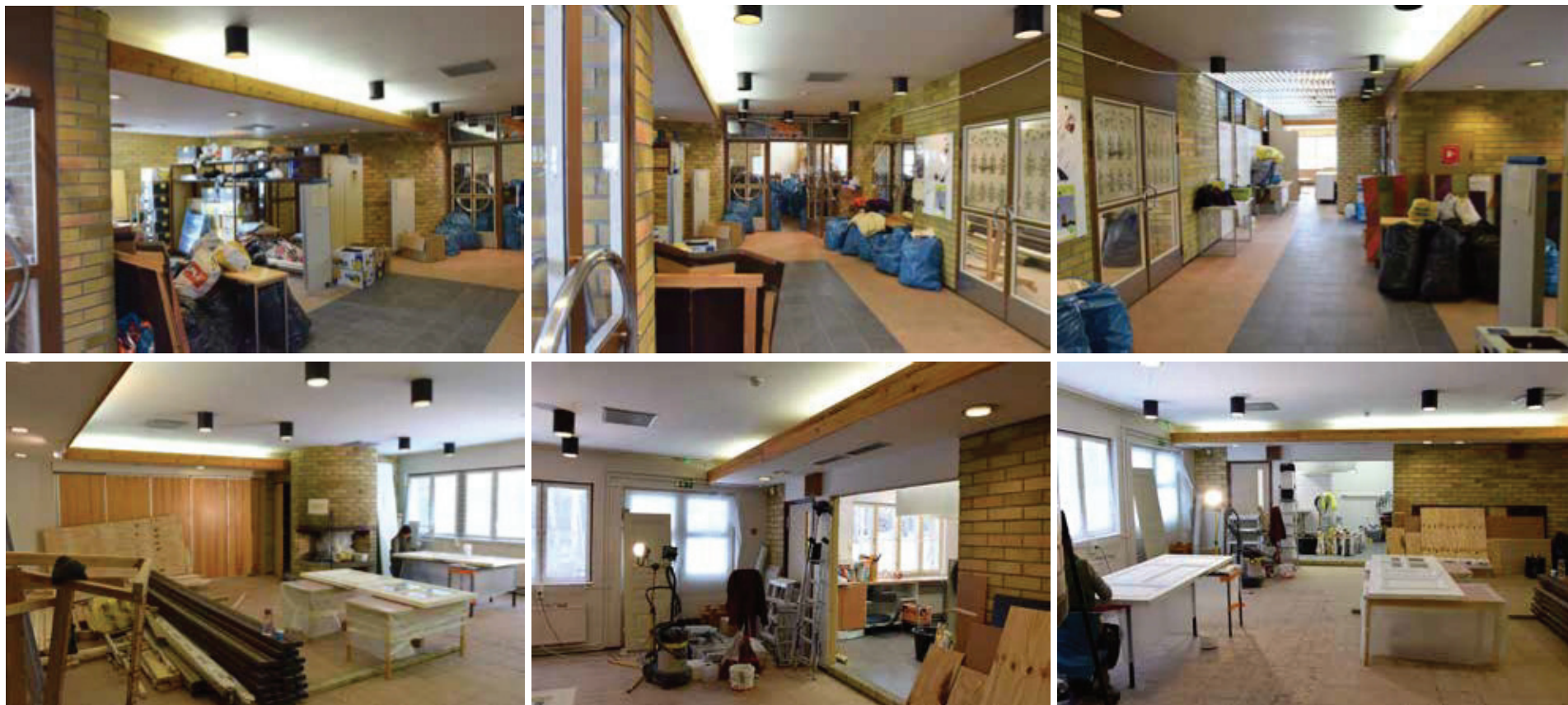
Ylärivillä käytävä. Oikean puoleisessa kuvassa näkyy valokuilun metallinen säleikkö. Vasemmalla naulakkojen kohdalla on alaslaskettu katto, jonka kautta epäsuora valaistus. Alarivillä kahvio, joka on taitto-ovella yhteydessä seurakuntasaliin. Avotakka on tilassa keskeisellä paikalla.
