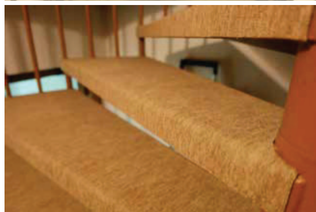
Ylä- ja alakuvassa teräsrakenteinen kierreporras.
