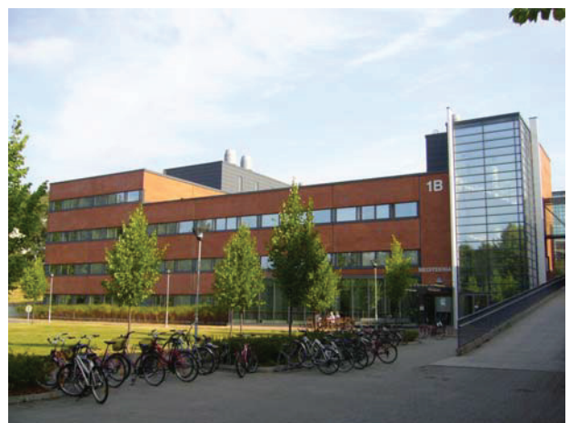
Mediteknian julkisivu etelään
