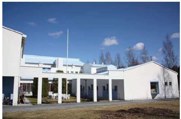
Studentian julkisivu etelään
