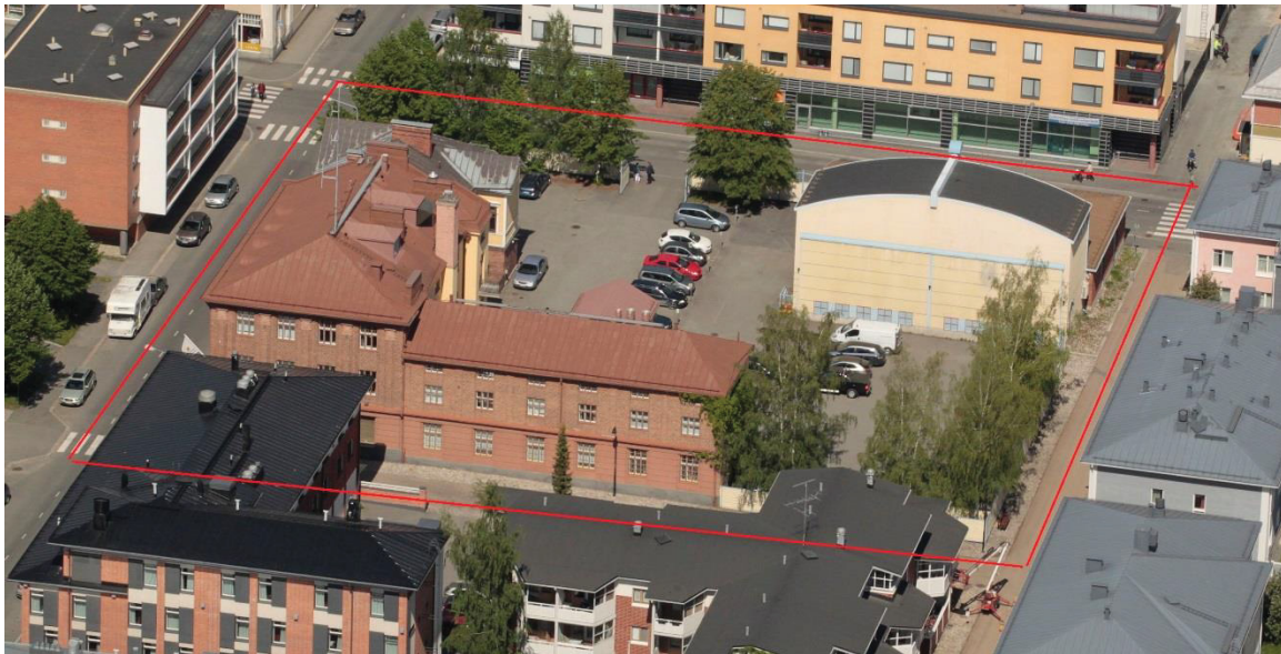
Kuva 2.1. Ilmakuva Kuopion Energian toimitilojen ja sähköaseman tontista. Muuntamo kuvassa oikealla ylhäällä rajausten sisällä, vaaleampi seinäinen rakennus.
