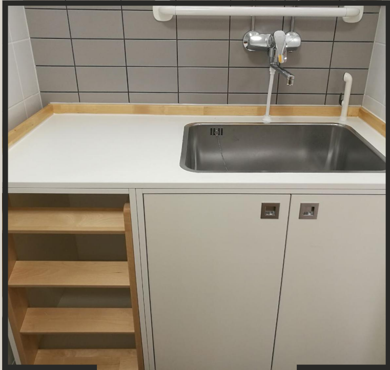
Hyvä esimerkki hoitopöytäkalusteesta, jossa riittävän syvä pesuallas sekä integroidut tikkaat. (Päivärannan päiväkot).
