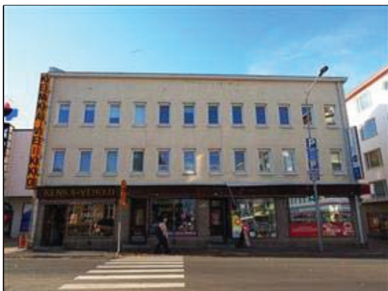
Pääjulkisivu Haapaniemenkadulla. (A. Mustonen 2.10.2018)
