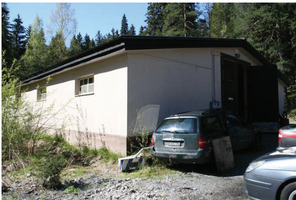
Kuva 11. Varastorakennuksen (rakennus 56) pohjoispääty ja itäsivu, kuva Aada Mustonen.
