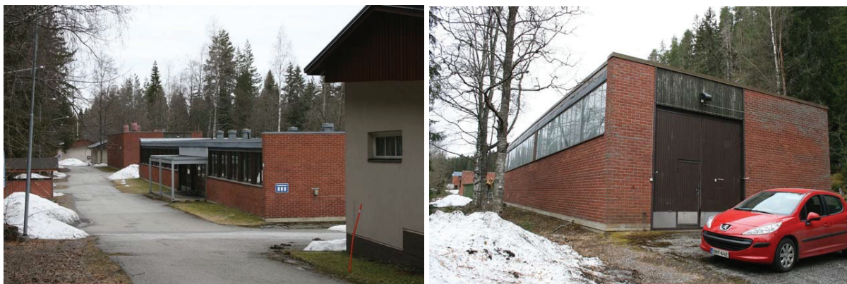
Kuva 15. Vasemmalla nahkalyöverstaani (rakennus 153) länsisivu ja oikealla maalaamon (rakennus 154) itäisivu ja pohjoispääty, kuvat Aada Mustonen.
