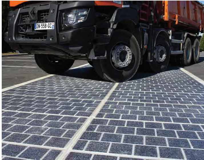
Kuva 2-13 Tien päällystäminen aurinkopaneelilla. (Kuva: Wattway)
