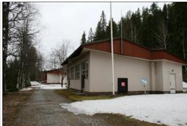
Rakennuksen 16 pohjoispääty. Takana rakennus 15. (Aada Mustonen 21.4.2015)
