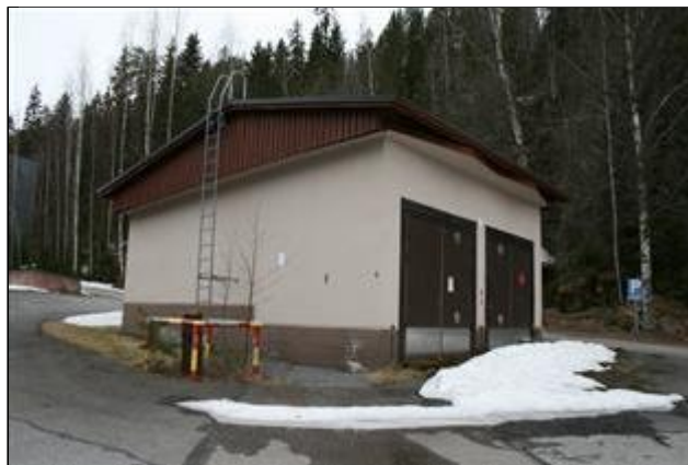
Rakennus 13 itäpääty ja pohjoissivu. (Aada Mustonen 21.4.2015)
