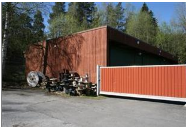
Rakennuksen 134 itäpääty ja aidan takana pohjoissivu. (Aada Mustonen 22.5.2015)
