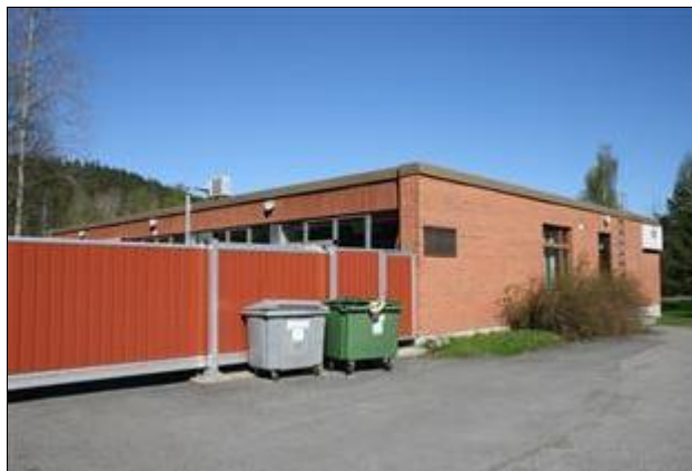
Rakennus 133 itäpäätty ja aidan takana eteläsivua. (Aada Mustonen 22.5.2015)
