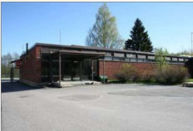
Rakennus 131, eteläsivua ja länsipäätä. (Aada Mustonen 22.5.2015)
