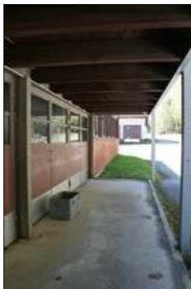
Rakennus 153, näkymä länsisivun katoksen alta. (Aada Mustonen 22.5.2015)
