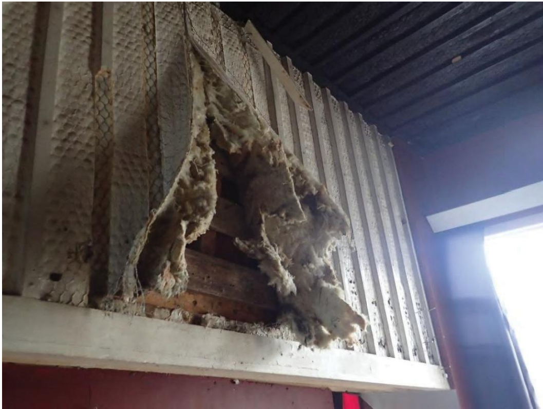
Kuva 13. Kantava puurakenteinen palkki salin kohdalla.
