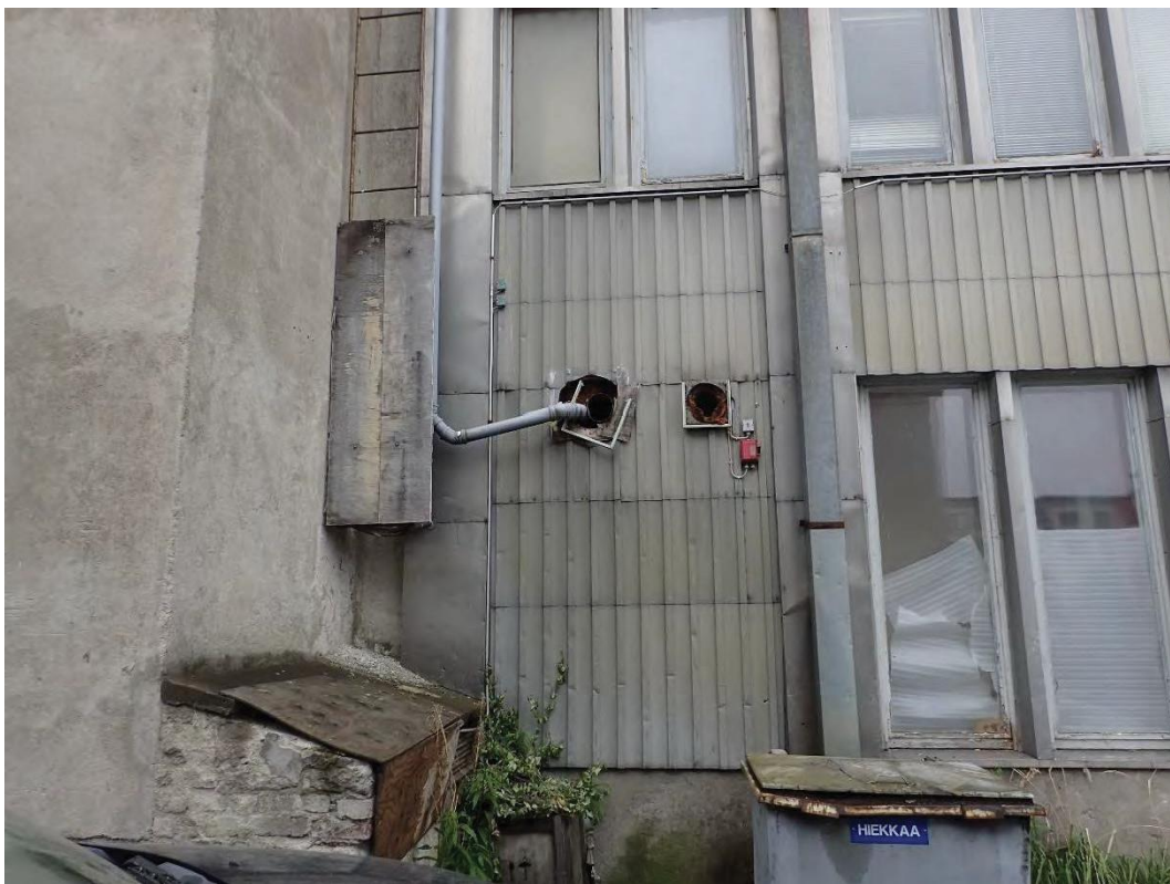
Kuva 5. Kuva julkisivusta sisäpihalta.
