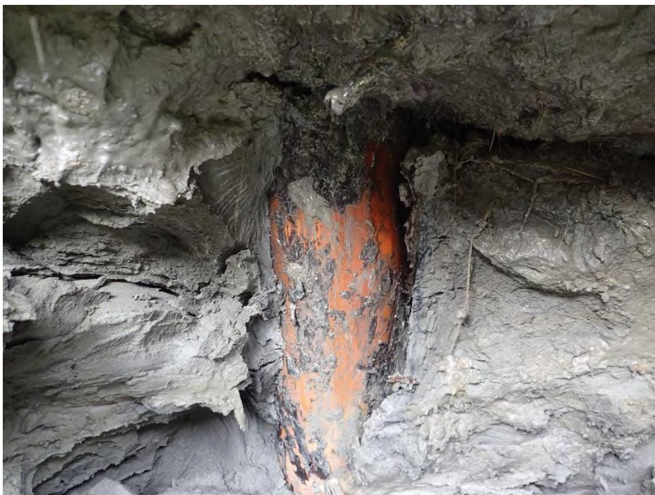
Kuva 2. Esiin kaivetun puupaalun yläpää.
