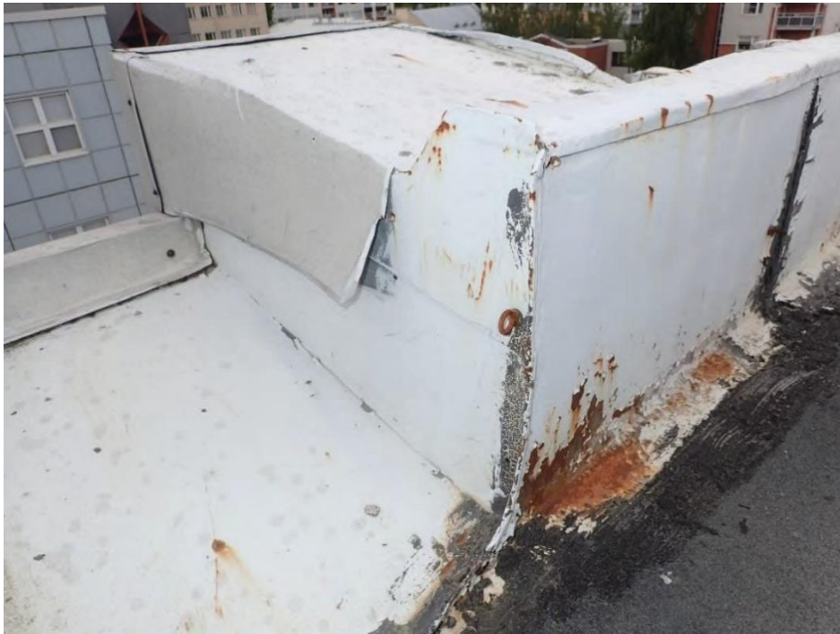
Kuva 9. Kuva pellityksestä pilarin yläpään kohdalla.
