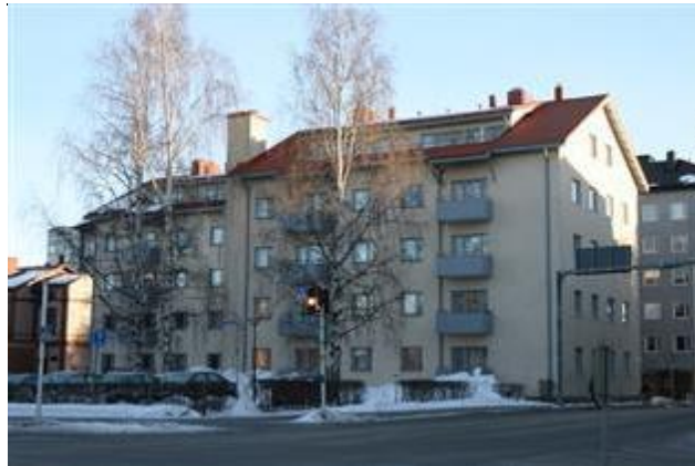
Puistokadun puoleinen länsisiivu ja Suokadun puoleinen eteläpääty Puistokadulta kuvattuna. (Aada Mustonen 13.2.2015)
