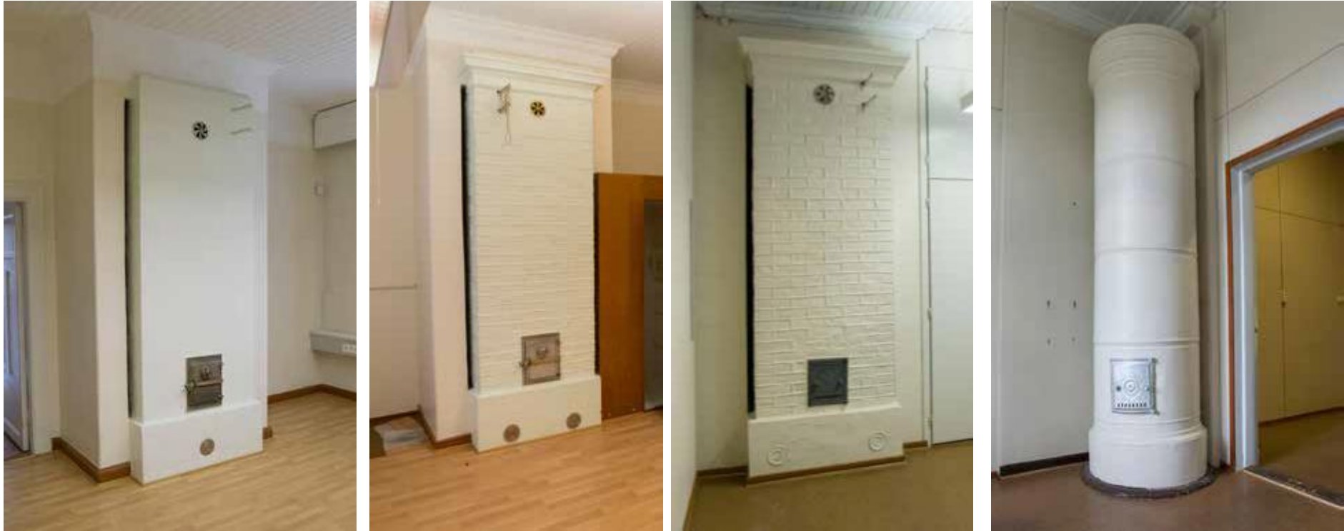
Rakennuksessa on säilytetty useita tulisijoja, vaikka lämmitystapa on muutettu keskuslämmitykseksi. Alun perin jokaisen asunnon suurimmassa huoneessa oli muurattu pystyuuni (yht 8 kappaletta) ja keittiöissä liedet. Muuratuista pystyuuneista on säilynyt kuusi kappaletta. Lisäksi ensimmäisen kerroksessa on säilynyt yksi peltikuorinen pönttöuuni.
