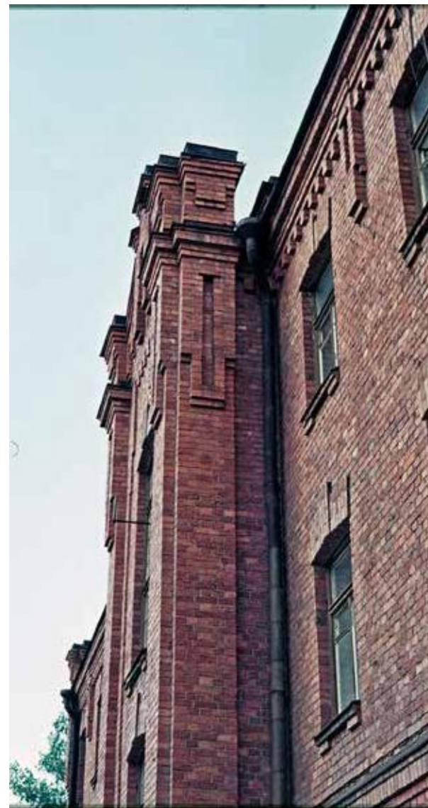
Venäläistä punatiiliarkkitehtuuria rakennettiin Suomeen 1910-luvulla. Julkisivut koristeluineen on säilytetty alkuperäisinä. Arkistokuva vuodelta 1972. KUHMU, Antero Nederström
