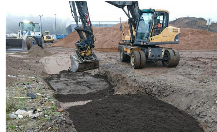
Jättekukon alueella testataan tuhkan hyödyntämistä katurakenteissa. (Kuva: Jättekukko Oy)
