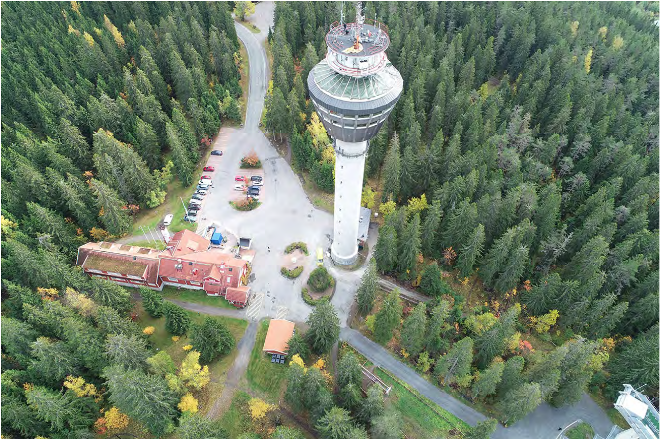
Kuva 73. Dronekuva Puijon tornin ja majan piha-alueesta.
