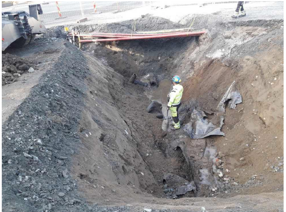
Kuva 10. Jätevesiviemäriinlinjan uusiminen Niiralankadun suuntaan syyskuussa 2018. HDPE kalvo näkyvissä kuvassa etualalla.
