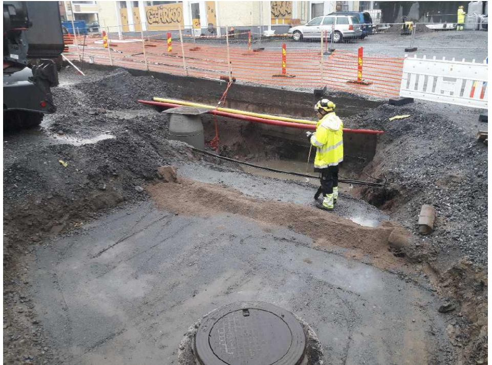
Kuva 9. Jätevesiviemärin Niiralankadulla sijaitseva liittytäkäivo kuvan etualalla. GRK Oy oli täyttänyt kaivannosta jo suurimman osan. Huoltoaseman kaiteen betoniperustus näkyvissä johtoputkien takana.
