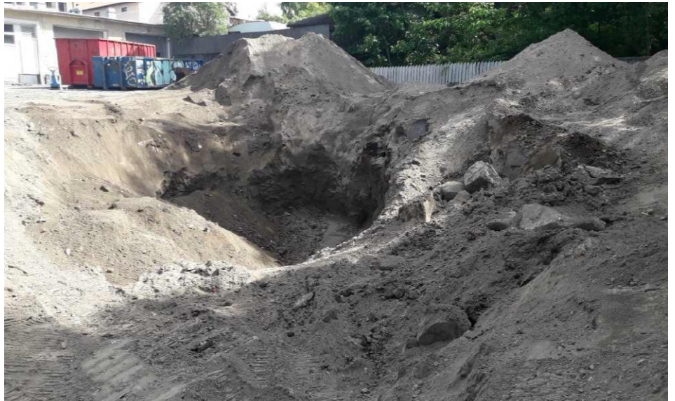
Kuva 4. Kiinteistön länsilaidan säiliökaivannot kuvattuna pohjoisesta.
