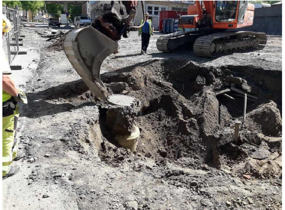
Kuva 1. Öljynerotinkaivon poisto. Pohjoisimman säiliön kansi näkyvissä oikealla.
