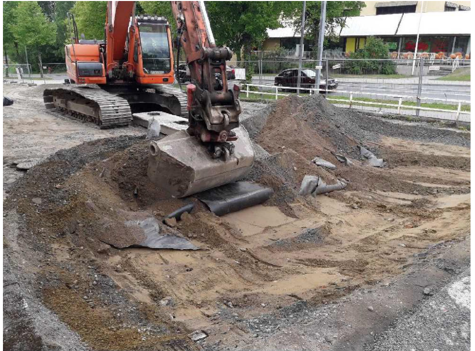
Kuva 5: Vanhan mittarikentän maanalaisten rakenteiden purku alkaa.
