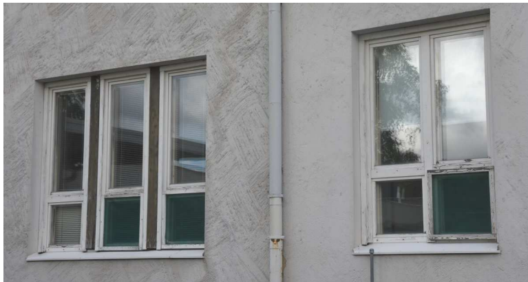
Vasemmalla.1965 laajennusosaa, oikealla alkuperäistä
