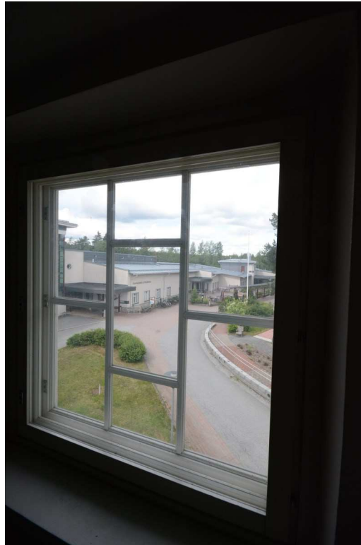
Ylempi porrashuoneen ikkunoista sisäpuolelta. Ikkunat eivät ole alkuperäisiä.
