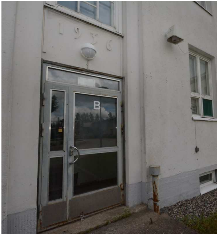
Kivelän pääsisäänkäynti. Ovi ei ole alkuperäinen.
