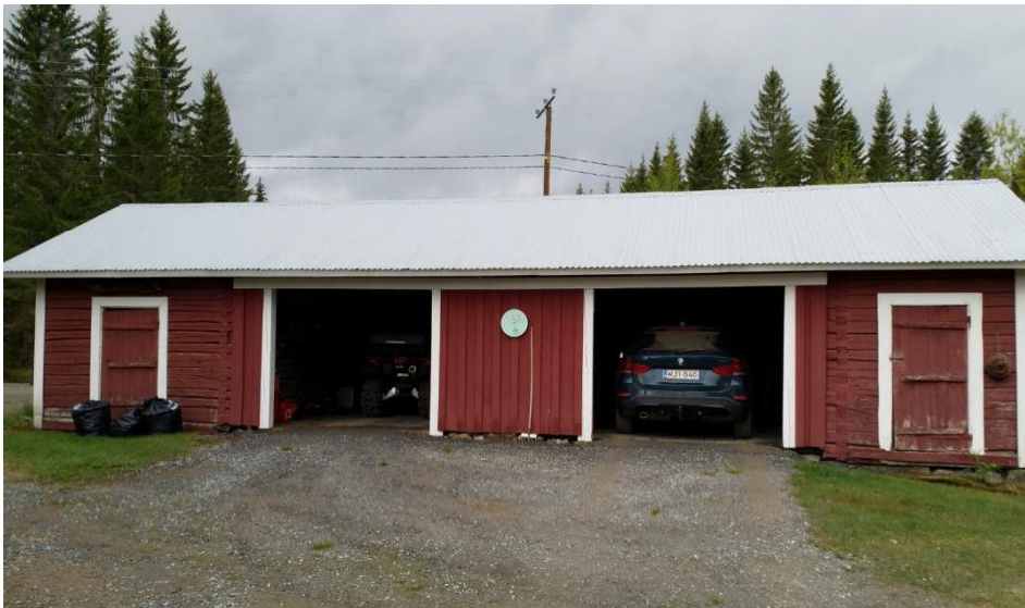
Kuva: Aitta / autotali rakennus.
