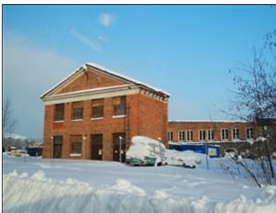
Rakennus vuonna 2021. Takaosa purettu. (Aada Mustonen 04.02.2021)
