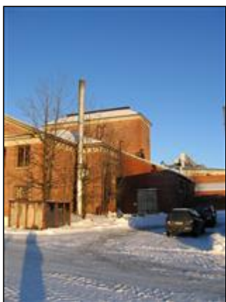
Kattilahuonee sahalta. (Merja Marin 11.1.2005)
