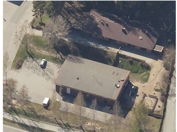
Kuva 8 Puistolan päiväkoti. Päiväkotirakennus yläreunassa.
