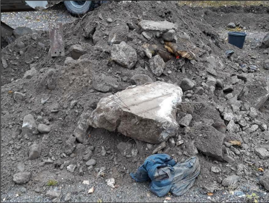
Kuva 3. Koekuopassa LP20 havaittiin betoniset perusrakenteet, joiden välissä olleen maa-aineksen seassa esiintyi jätekappaleita
