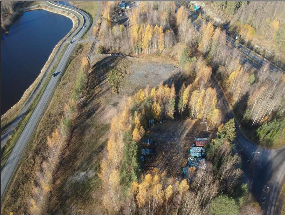
Kuva 1. Viistoilmakuva kiinteistöstä 297-8-9908-0 kaakosta.
