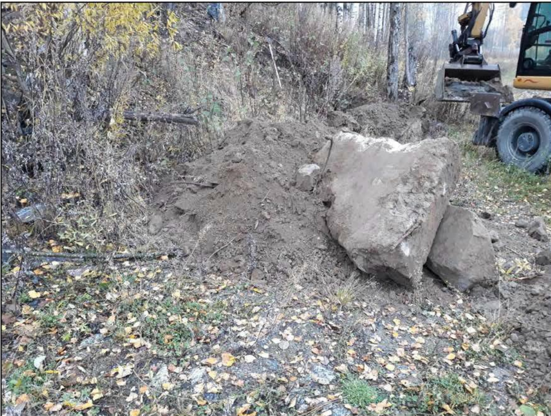
Kuva 4. Koekuopassa LP25 pintakerroksessa ollut betonilohkare
