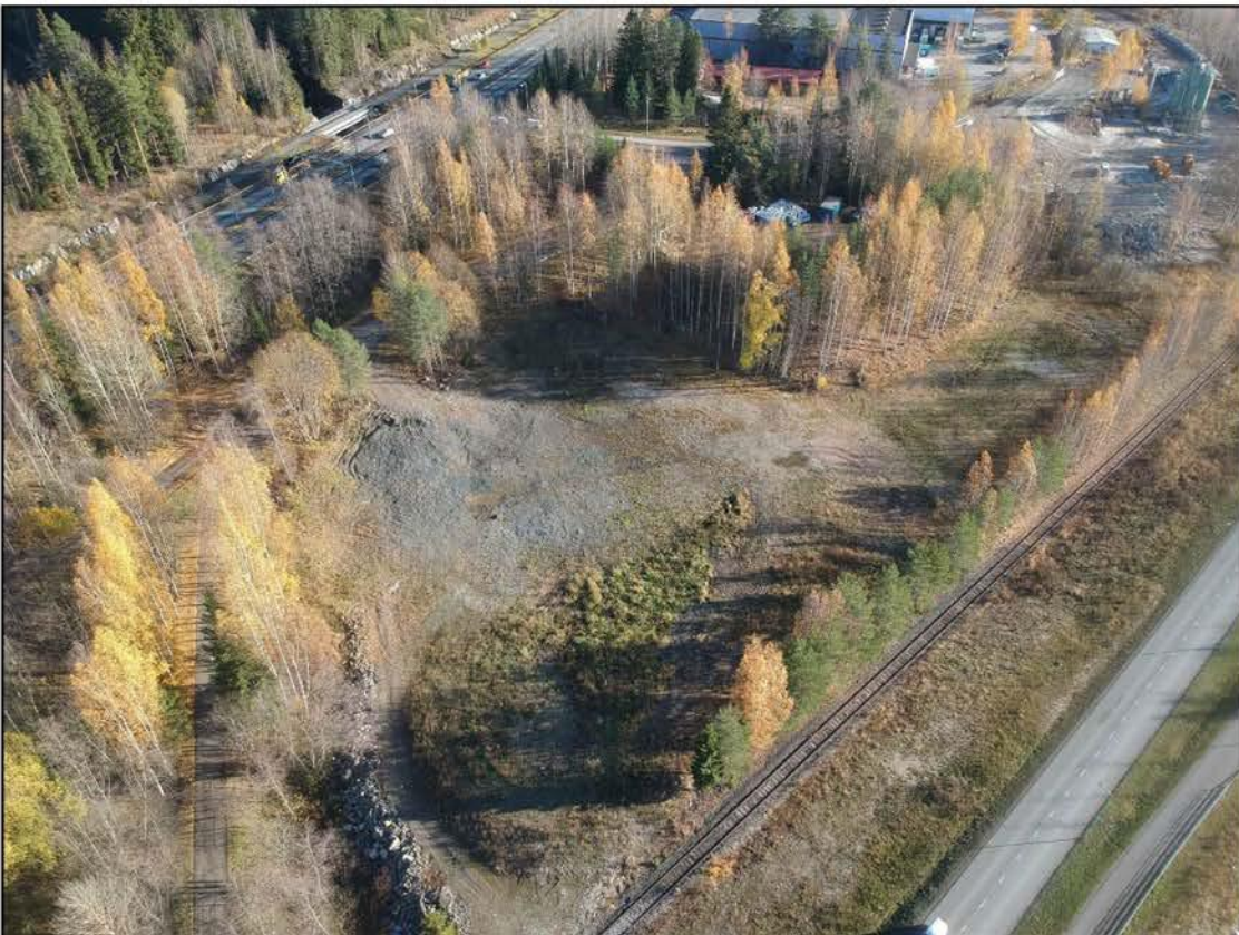
Kuva 2. Viistoilmakuva kiinteistöstä 297-8-9908-0 länsi-luoteen suunnasta. Kevyen liikenteen väylälle kuvan vasemmassa laidassa.
