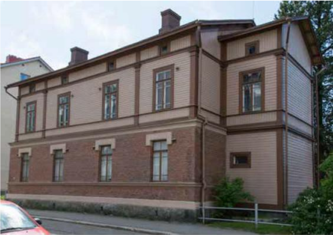
Kuva 11. Vuonna 1900 valmistuneen Nälkälinnan nykytilanne, rakennuksen alkuperäinen muoto ja ulkoasun pääpiirteet on säilytetty. Kuva rakennushistoriaselvityksestä.
