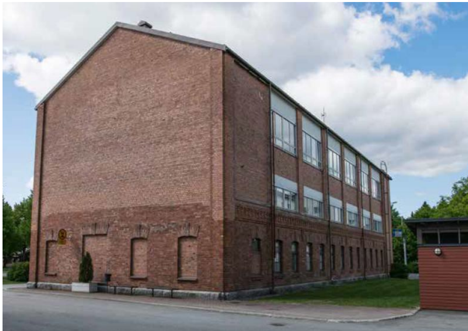
Kuva 5. kuva pohjoisen vuonna 1914 valmistuneen kasarmirakennuksen nykytilanteesta. Rakennuksen julkisivusta erottuu selkeästi eri aikoina valmistuneet kerrokset. Kuva rakennushistoria selvityksestä
