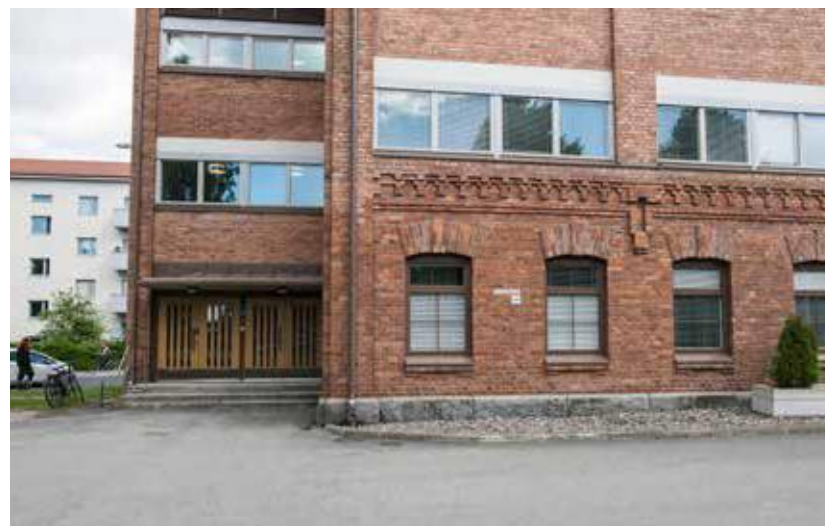
Ensimmäisen kerroksen sisäänkäynnin risaliitti on säilytetty korotusvaiheessa, mutta kaikki koristeaiheet on purettu siitä pois. Rakennuksen pohjoispäätyn tehtiin uusi porrashuone korotusvaiheessa 1950-luvulla.
