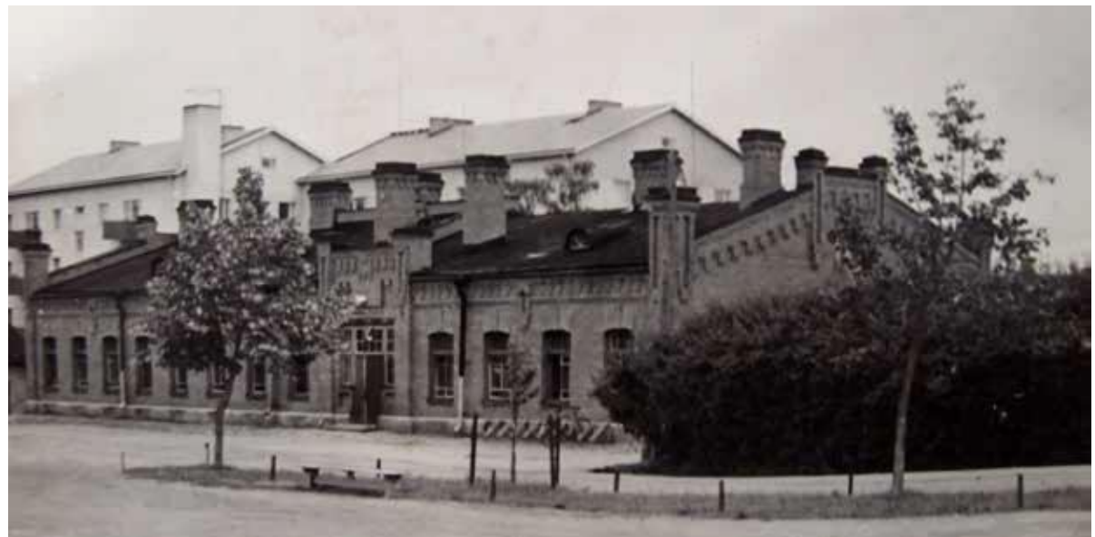
Rakennus kuvattuna lännestä vuonna 1956, ennen korotusta. PhRakI
