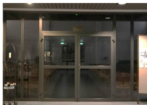
KUVA 74. Metallirakenteinen lasiväliovi seurakuntasaliin (Pätynen 2019)
