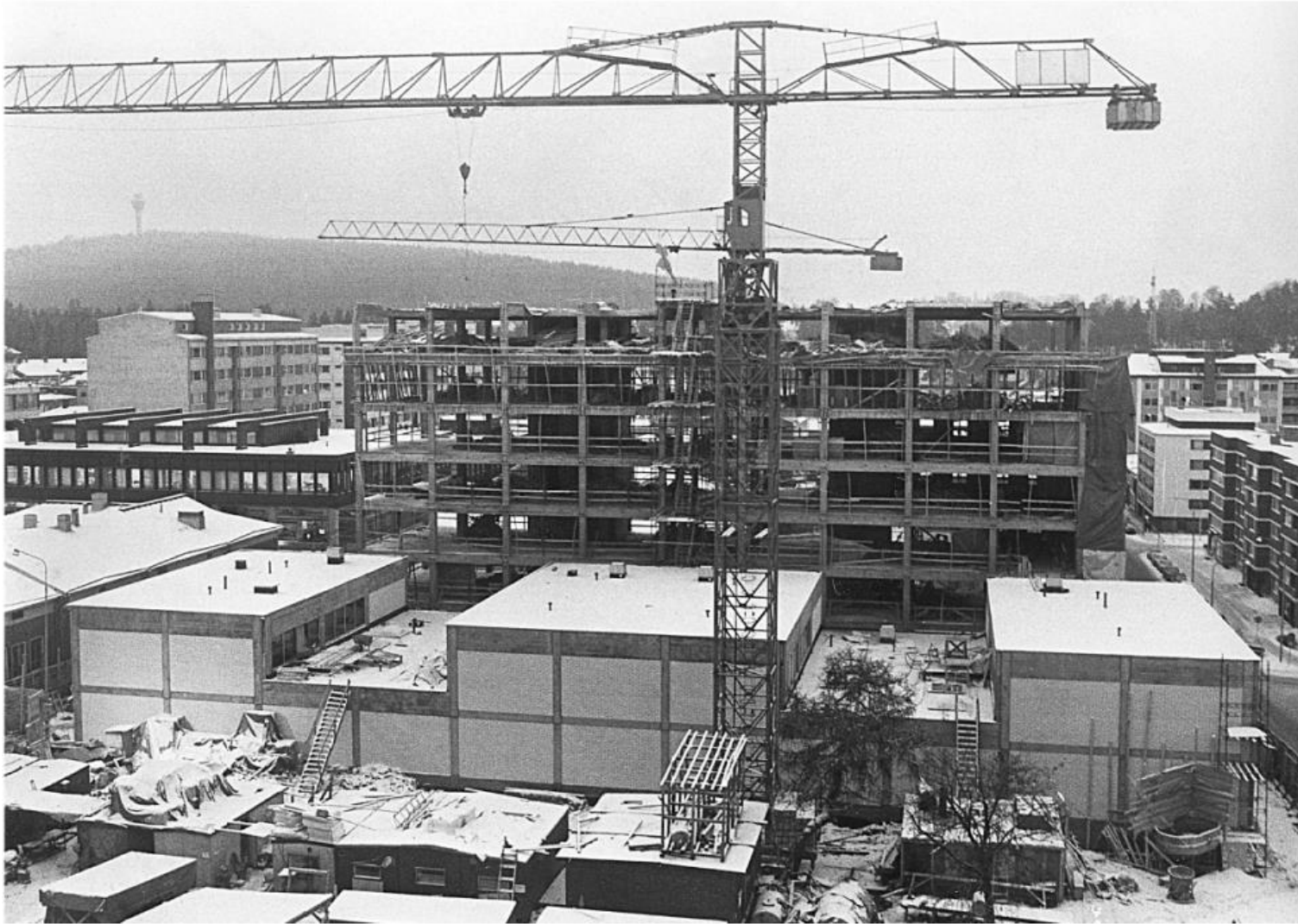
KUVA 44. Rakennustyömaa käynnissä (Kirkko ja koti)
