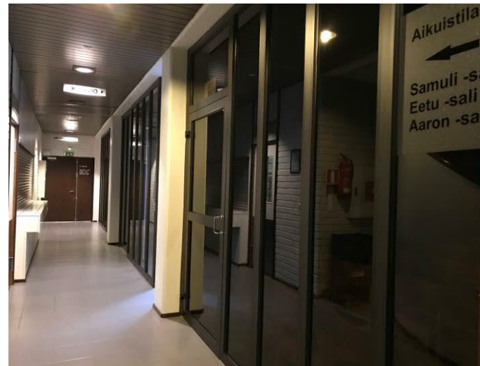
KUVA 80. Sisälasseinää (Pätynen 2019)
