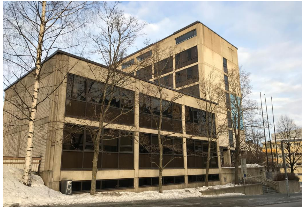
KUVA 78. Ikkunoita ja lasijulkisivua (Pätynen 2019)
