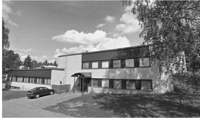
KUVA 21. Kuoppakankaan työkeskus Varkaus, valmistunut vuonna 1964 (google.maps.fi)
