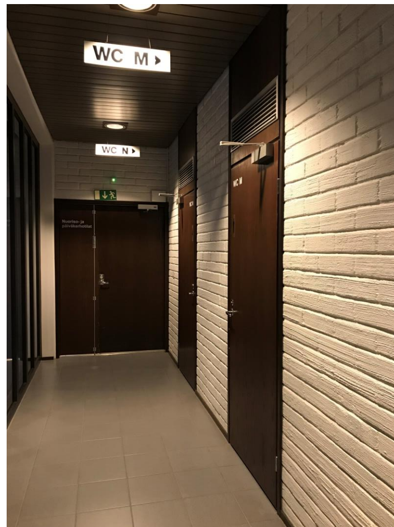
KUVA 69. Uusi lattialaatta ja alkuperäiset katto- sekä seinäpinnat (Pätynen 01/2019)
