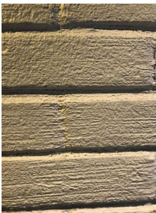
KUVA 68. Puhtaaksi muurattu ja slammattu tiili (Pätynen 01/2019)
