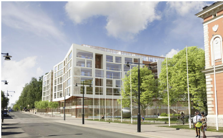
Kuva 25. Tullinkulma Tulliportinkadulta idästä nähtynä, Arkkitehtipalvelut Oy
