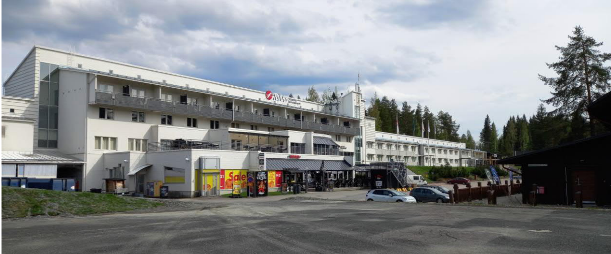
KUVA 6. SOKOS-HOTELLIN RAKENNUS LÄNNESTÄ KATSOTTUNA. (kuva Aada Mustonen 2021)
