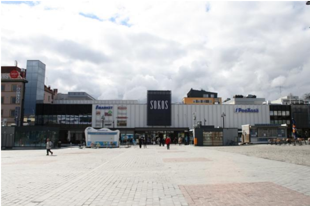
Kuva 5. SOKOKSEN LIIKERAKENNUS. KUVA: KUOPION KESKUSTAN JA LÄHIYMPÄRISTÖN MODERNIN RAKENNUSPERINNÖN INVENTOINTI, AADA MUSTONEN.
