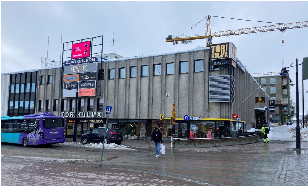
Kuva 4. KOY HAAPANIEMENKATU 28, TORIKULMAN LIIKERAKENNUS. KUVA: JAANA KERÄNEN.
