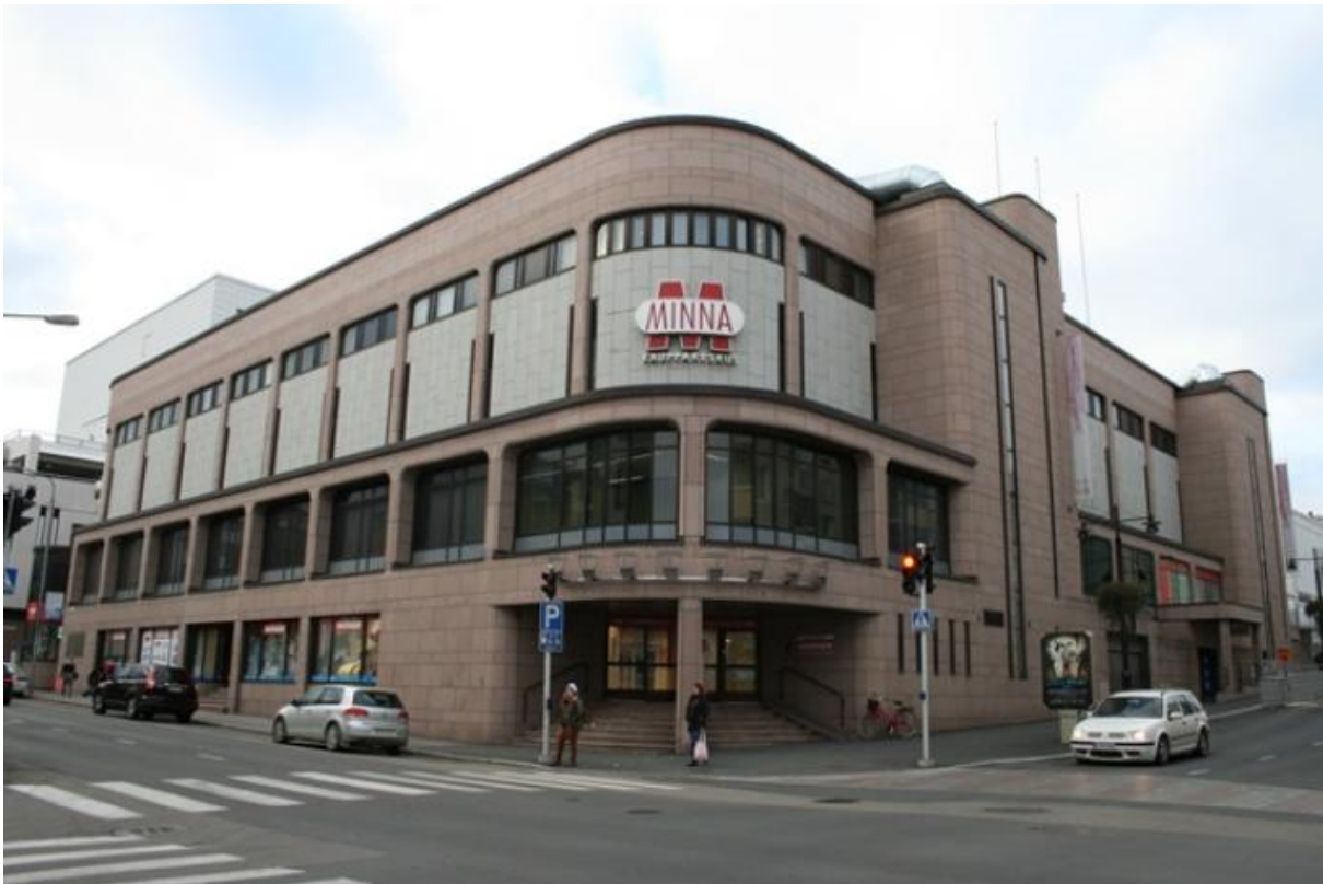
Kuva 8. KAUPPAKESKUS MINNA. KUVA: KUOPION KESKUSTAN JA LÄHIYMPÄRISTÖN MODERNIN RAKENNUSPERINNÖN INVENTOINTI, AADA MUSTONEN.
