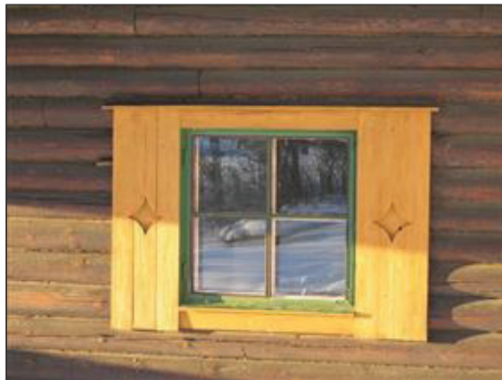
Saunan ikkuna. (Merja Marin 11.1.2005)
