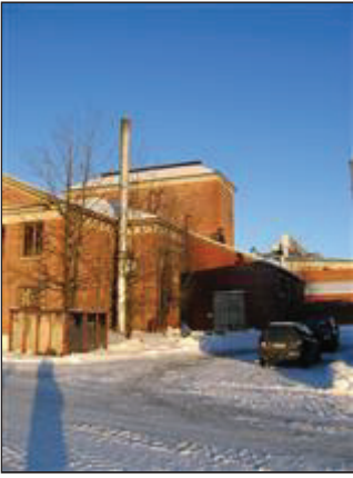
Kattilahuonee sahalta. (Merja Marin 11.1.2005)
