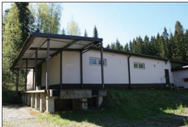
Rakennuksen 50 pohjoissivua ja itäpäätä. (Aada Mustonen 22.5.2015)
