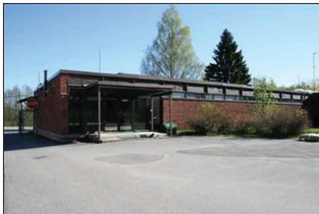
Rakennus 131, eteläsivua ja länsipäätyä. (Aada Mustonen 22.5.2015)
