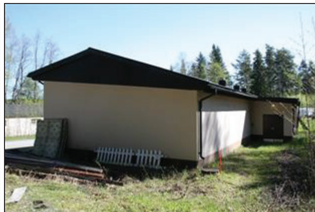
Rakennuksen 47 länsipääty ja eteläsivu. (Aada Mustonen 22.5.2015)
