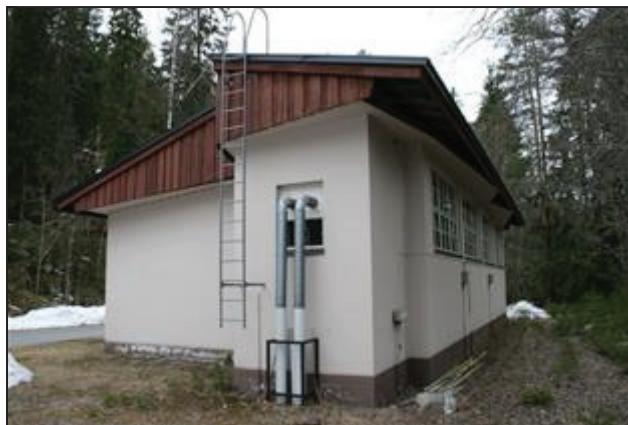
Rakennuksen 20 eteläpääty ja itäsiivu. (Aada Mustonen 21.4.2015)
