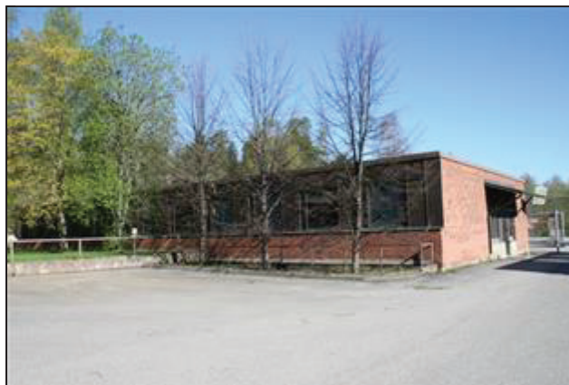
Rakennuksen 130 eteläsivu ja itäpääty. (Aada Mustonen 22.5.2015)
