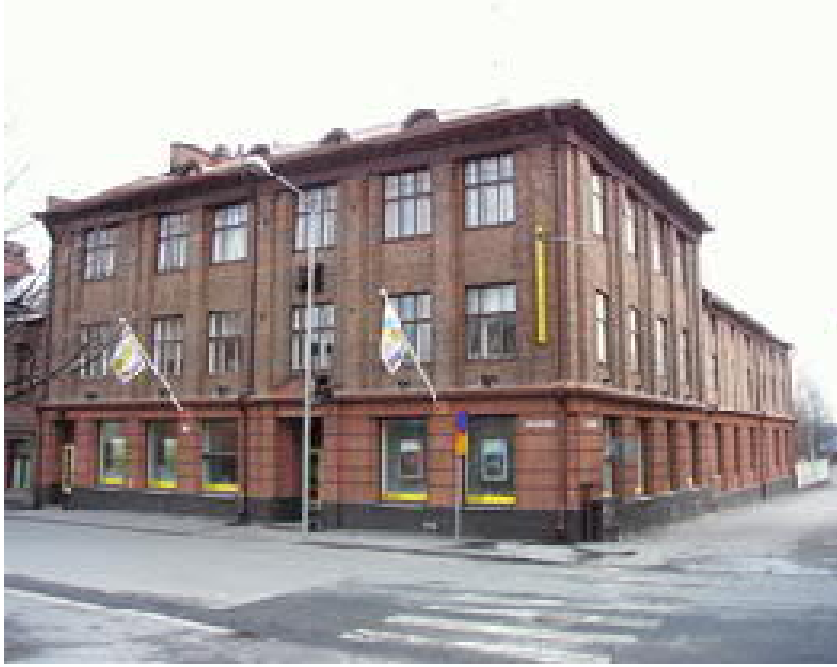
KUVA 5. VUONNA 1921 VALMISTUNUT PUNATIILINEN OSA
