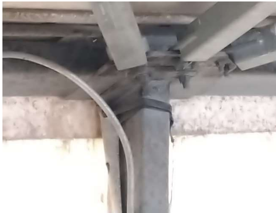
Kuva 10: Pohjoispääty, kattoristikon tukipiste
