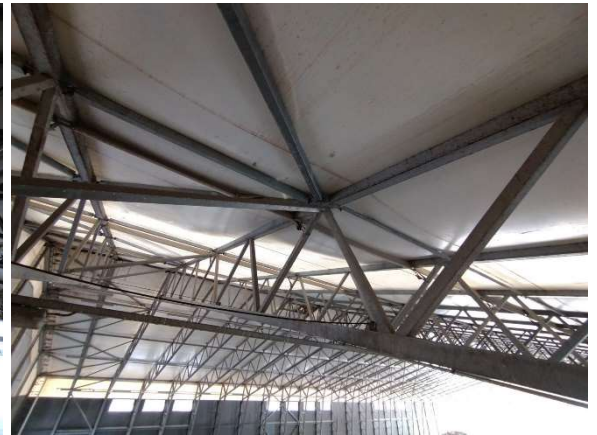
Kuva 7: Kattoristikon tukipiste
