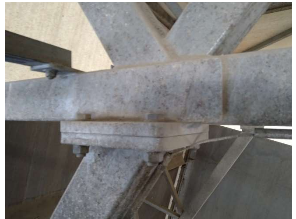
Kuva 11: Kulkuaukon tukipiste (länsisivu/kuva 1.)
