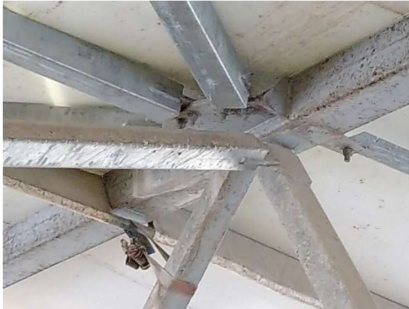
Kuva 8: Kattoristikon tukipiste, lähikuva
