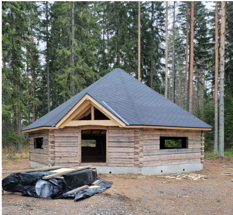
Rakenteilla oleva kota. Kuva viime syksyltä.
