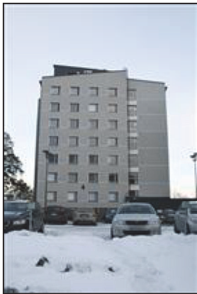
Rakennuksen luoteissivu. (Aada Mustonen 14.2.2017)
