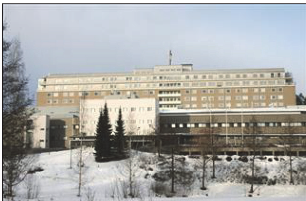
Sairaalan eteläisivu kohoaa uudempien osien takana. (Aada Mustonen 14.2.2017)
