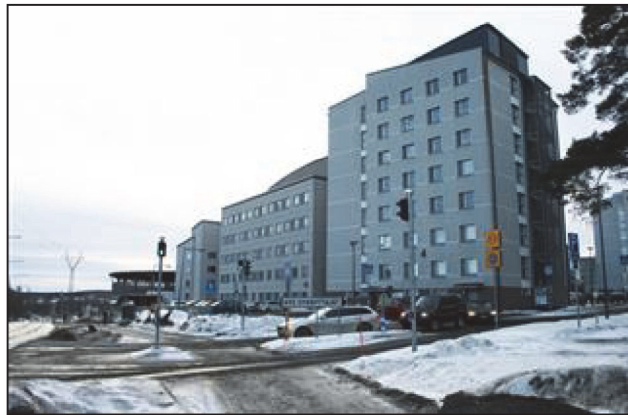
Rakennus etummaisena, taaempänä uudisosa, entinen ailiääkärien asuinkerrostalo ja pyöreä pysäköintilaitos. Kaakkoissivua Puijonlaaksontien varrella. (Aada Mustonen 14.2.2017)
