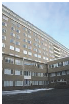
Sairaalan eteläisivua sisäpihalta kuvattuna. (Aada Mustonen 14.2.2017)
