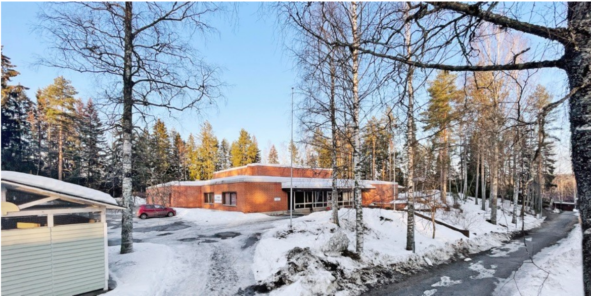
Kuva 7. Rakennuspaikalla sijaitseva Monarin nuorisotalo, joka puretaan hankkeen alta huonokuntoisena. Nykyinen Aittolammen päiväkoti, joka myös puretaan tontilta, jää kuvassa oikealle.
