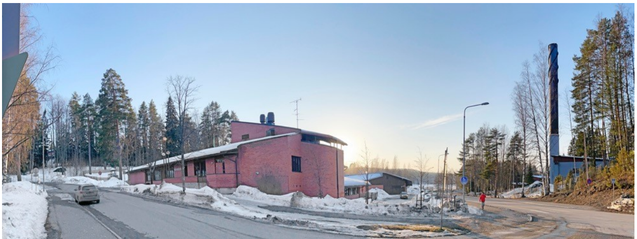
Kuva 2. Nykyinen päiväkotirakennus Leirikyläntien ja Mullinpolun risteyksestä kuvattuna.
