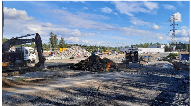
Savilahdentien ja Volttikadun risteuksen työmaa
