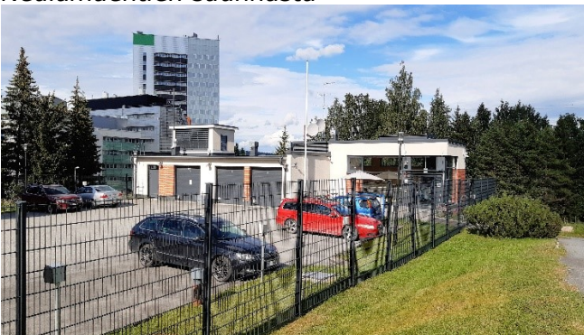
Hälytyskeskus. Takana näkyy MicroTower.
